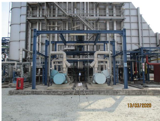
Boiler Feed Pump HRSG#12
